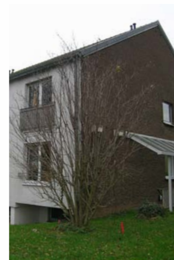
einzelne Fassaden in Ziegelmauerwerk, gemischt mit Mineralputzfassaden
