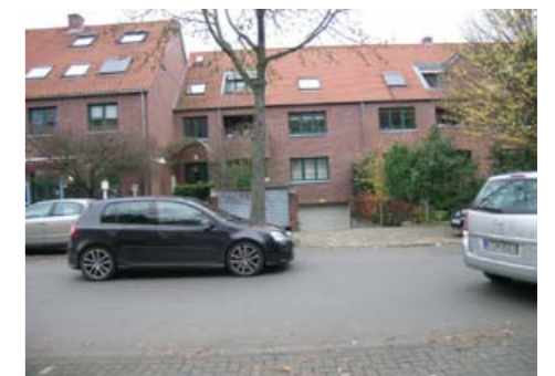
Beispiele für eine geschlossen wirkende Bauweise entlang der Werthmannstraße
