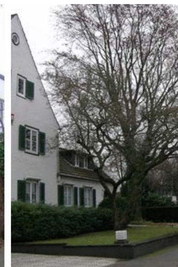
Mineralputzfassaden, Einfassungsmauern in Ziegelmauerwerk
