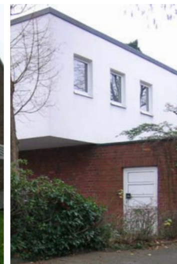
Gesamtes Erdgeschoss in Ziegelmauerwerk darüber Mineralputzfassaden
